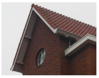
Het zadeldak van het linkerbouwdeel van volume B is belegd met rode, gesmoorde dubbele opnieuw verbeterde holle dakpannen. Verder is deze dakrand voorzien van een houten windveer en wordt deze afgetopt met een laag rode, gesmoorde gevelpannen, met in de punt een eindvorstpan.
