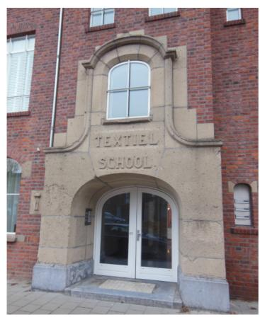
Onderaan, op het begane grondniveau bestaat de entreeomlijsting uit een licht uitstekend betonnen postament, waarvan de bovenzijden geprofileerd zijn. In de portiek staan twee moderne getoogde glas-houtdeuren, gevat in getoogde kozijnen. Centraal op de entreeomlijsting is, boven de entree, in reliëfletters de tekst "TEXTIELSCHOOL" uitgehouwen.
