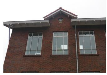
Zowel op de eerste als op de tweede verdieping van volume A zijn zeven rechthoekige negenruits vensters aangebracht, voorzien van margeroeden. Centraal in elk van de twee Vlaamse gevels is een klein, vierruits rondlicht als valraam aangebracht, waar omheen een halfsteense rollaag. Onderaan wordt de rollaag onderbroken door een tufstenen sluitsteen met halfrond lekgootje.
