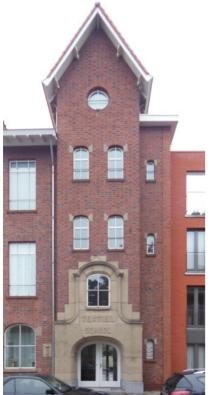
Links: zowel op de tweede als op de derde verdieping zijn twee smalle, getoogde, zesruits korfboogvensters aangebracht. De kozijnen en de horizontale middenroede zijn plat uitgevoerd, de verticale middenroede en de onderste horizontale roede hebben opstaande randen en liggen op de platte kozijnen.
