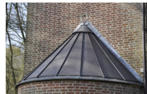
De dakbedekking van de absis (onder) met loodslab, topbedekking, koperen platen en afdekstrips (roeven)
